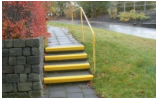
Vel merktar tröppur og handrið við hús Blindrafélagsins
